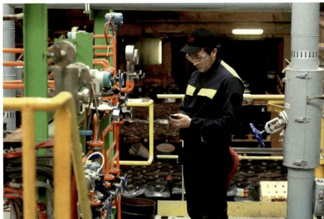
Pour les techniciens et gestionnaires de stocks, une application GMAO mobile optimise les pratiques de maintenance, avec les ordres de travail et les consignes. Ils peuvent flasher les entrées et sorties de pièces.
