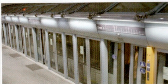
Las estaciones cuentan con puertas de acceso a los trenes
