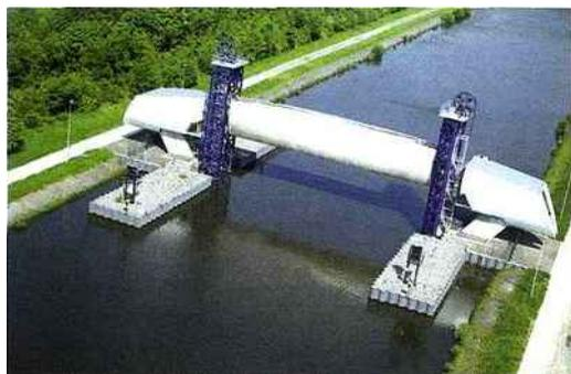
27 automates gèrent les manoeuvres des bacs et des portes (13 dans la tour, 6 sur chaque bac et 1 automate commun). 6 automates passerelles assurent le dialogue entre les automates du sol (dans la tour) et les automates embarqués (dans les bacs).
